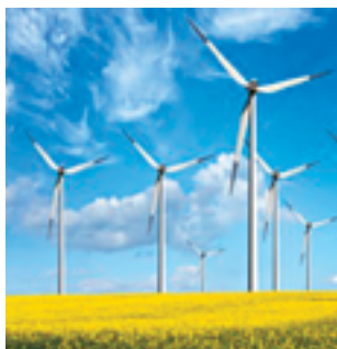
▲ Fig. 3.28 Valorificarea energiei eoliene
