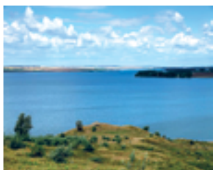
▲ Fig. 4.26 Lacul de acumulare Costești-Stânca
