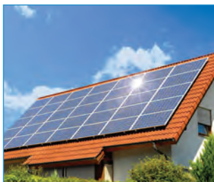
Sursă de energie – panouri solare
