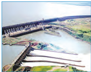
Hidrocentrala Itaipu, America de Sud
