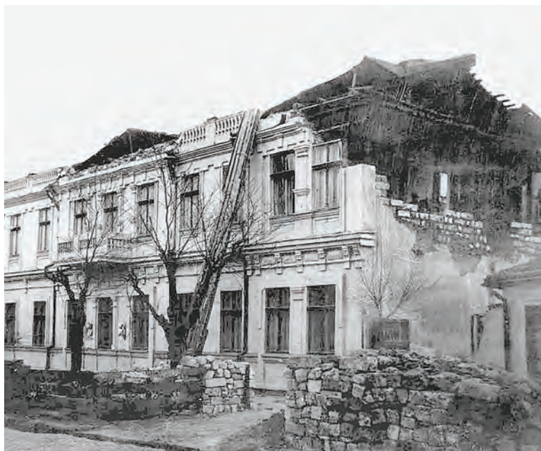
Рис. 1.19. Здание в городе Кишинёв, поврежденное в результате землетрясения 10 ноября 1940 года
