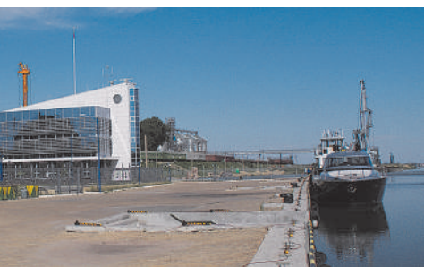
Fig. 4.19. Portul Internațional Giurgiulești (r-nul Cahul)
