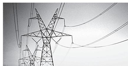
Fig. 3.7. Firele din aluminiu sunt ușoare și au o conductibilitate electrică înaltă.
