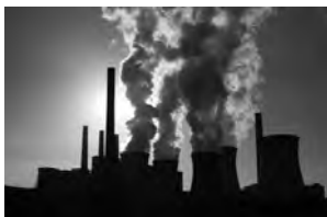
Рис. 5.5. Заводские трубы, не оборудованные фильтрами для улавливания загрязнений
