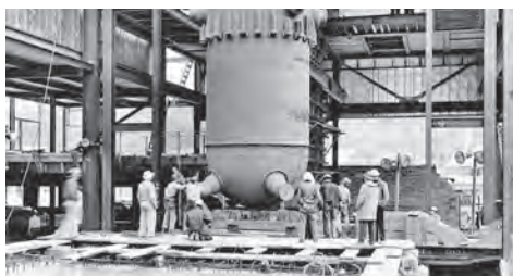
Instalarea unuia dintre primele reactoare nucleare de energie (60 MW). Shippingport NPP, SUA, 1956
