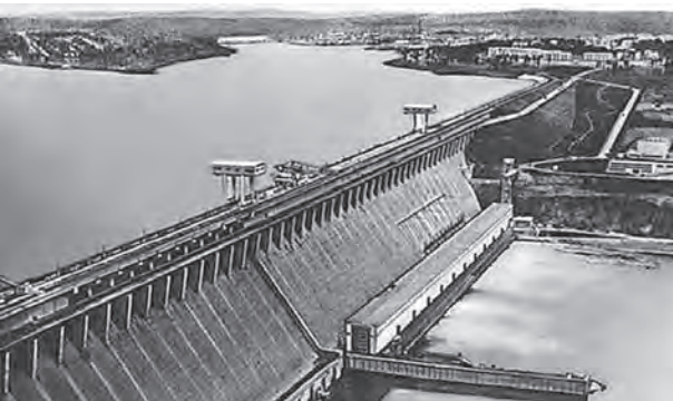
Construcția hidrocentralei din orașul Bratsk, 1954
