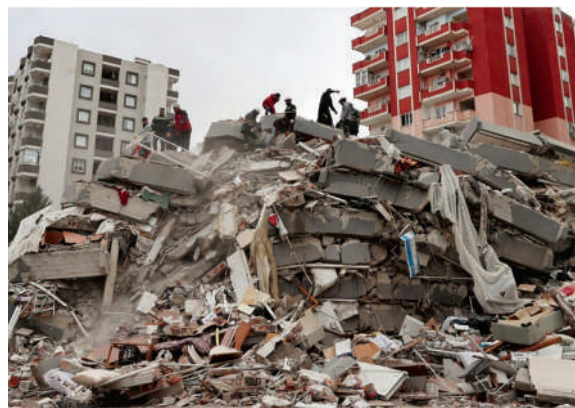
Рис. 22.1. Последствия землетрясения в Турции и Сирии (2023 г.)
