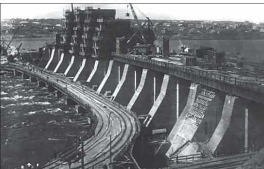
Строительство гидроэлектростанции на Днепре
