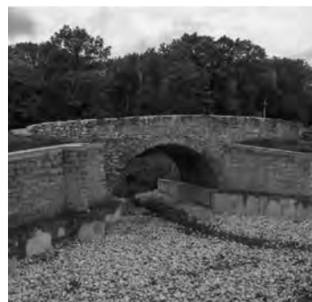
Кам'яний міст XVIII століття біля села Тецкань. Арку перекинуто через річку Вілія. Проліт арки – 6 метрів, висота – 4 метри.
